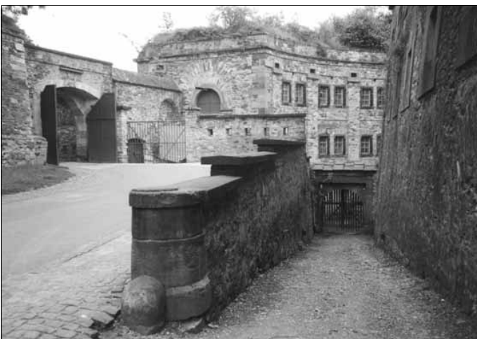
Vue intérieure de la forteresse en mai 1995
